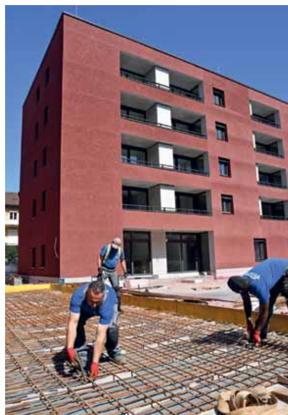
Nochmals sind Rohbauer am Werk. Sie legen das Fundament für ein Fahrrad- und Müllhäuschen.
