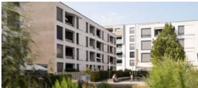
Innenhof der Wohnanlage am Niederfeldplatz
