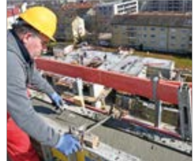
Die Attika wird betoniert, Stand 3/25
