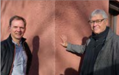
Sehr zufrieden mit diesem Kratzputz sind Architekt Udo Lay (rechts) und Marco Glockner, Technischer Leiter.
