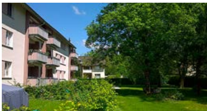
Wohnanlage Karlsbader Straße 18-20, Rückansicht
