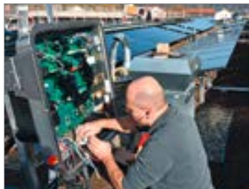
Hier wird ein großes Solarkraftwerk installiert. Stand 12/25.
