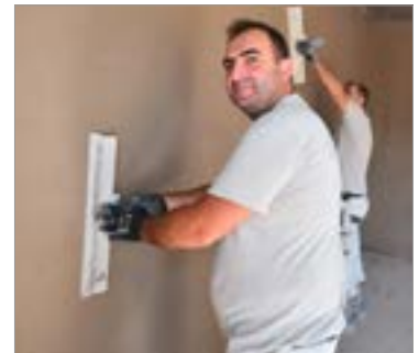
Die Gipsner verputzen die Wände. Stand 9/25.
