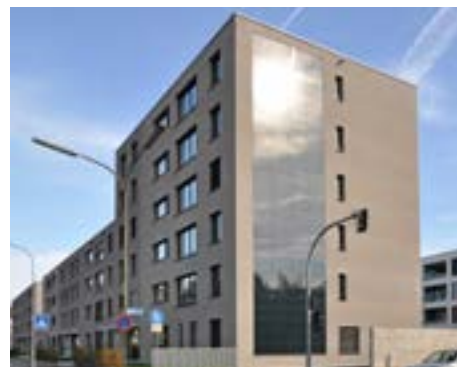
Ansicht Ecke Brühlstraße/Schillerstraße
